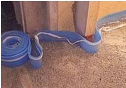
In questa prima fase dopo aver completato tutti gli impianti elettrici ed idraulici e ricoperti da un primo massetto ( che può essere come nell'immagine formato da lecca o materiale isolante leggero impastato a cemento, avviene la **stesura di una fascia perimetrale** che permetterà di compensare eventuali dilatazioni del pavimento e **isolare dalle pareti il massetto scaldante.**
