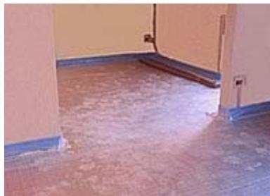
In queste due immagini si nota, una volta terminata la posa dei pannelli, **come la superficie del pavimento viene completamente isolata, cosa molto importante sia per il risparmio energetico, che per il fattore d'isolamento acustico.**
