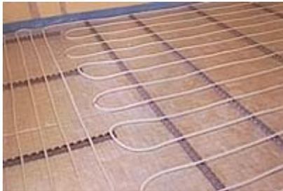
Nell'immagine si può osservare l'impianto completato, pronto a ricevere il massetto di cemento e fibre (sempre consigliate).
