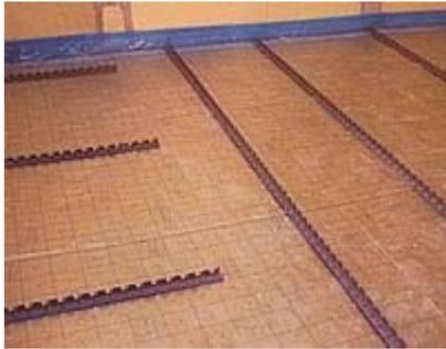
La **posa dei binari per alloggiare le serpentine**, come la stesura dei tubi stessi, avviene sotto progettazione di uno studio tecnico, il quale rilascia un progetto esecutivo con specificati i materiali più idonei alla formazione dell'impianto da realizzare.
