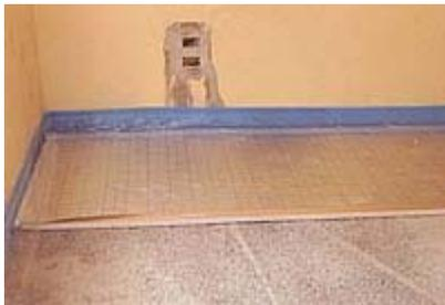
Nella successiva fase avviene la **posa del pannello isolante e riflettente** che ospiterà le serpentine scaldanti.
